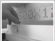
3. GENTLY TIGHTEN THUMB SCREWS ENSURING ADJUSTABLE BRACKET IS PRESSED LIGHTLY AGAINST DRYWALL. MAKE SURE NOT TO TIGHTEN ALL THE WAY.
